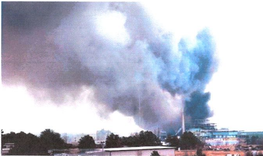
El Dorado incinerator, Arkansas: Fire 2005 (140,000 tpa)
